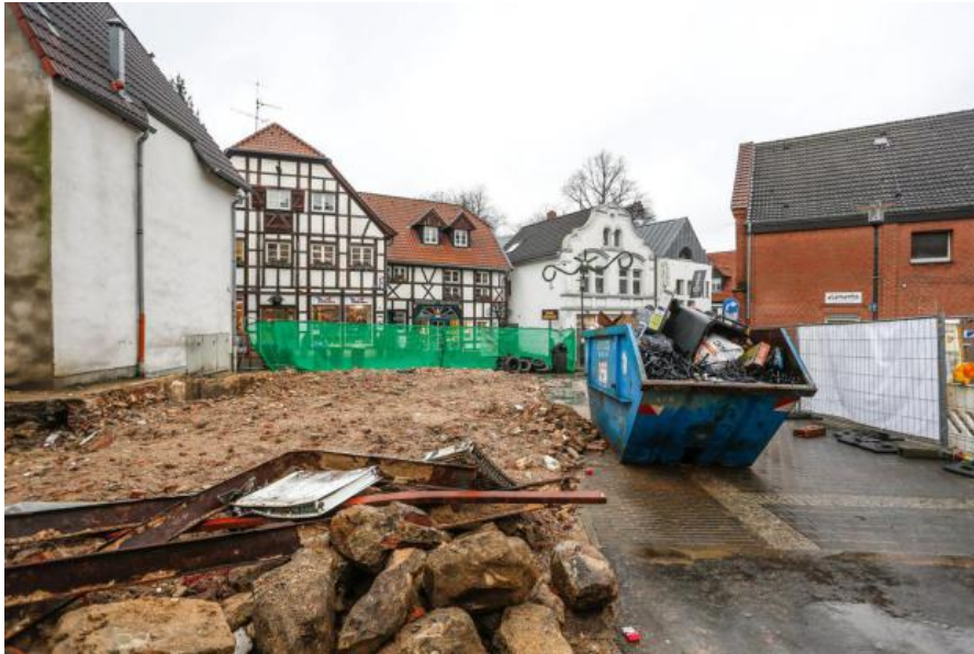
Der Abriss ist geschafft, im neuen Jahr geht es an der Johannes-Janssen-Straße an den Neubau des Museums für zeitgenössische polnische Kunst. Foto: Jörg Gutzeit
