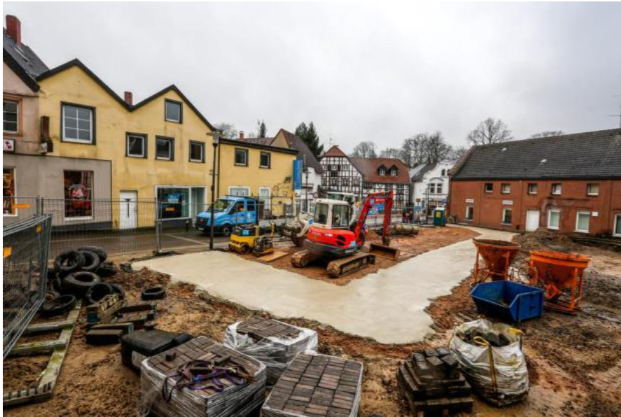
An der Johannes-Janssen-Straße rollen die Bagger. Foto: Jörg Gutzeit
