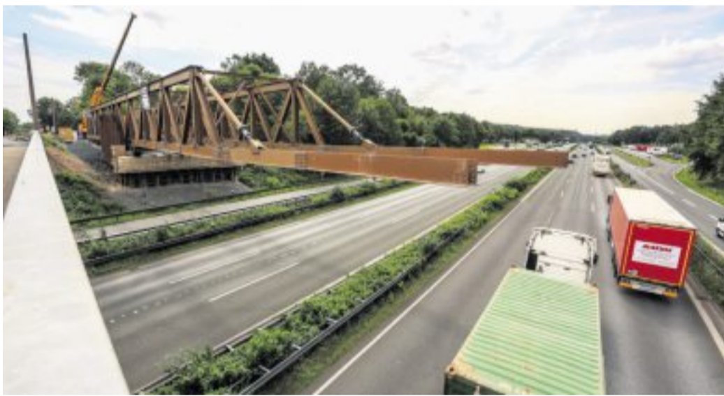
Schneller Baufortschritt: Eine stählerne Behelfsbrücke soll ein Jahr lang den Verkehr auf der Friedrich-Ebert-Straße über die A2 führen. –FOTO: GUTZEIT
